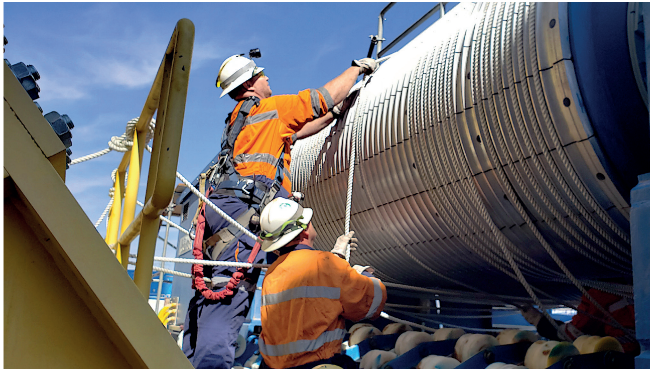
Pracownicy zespołu serwisowego podczas prowadzenia prac na mobilnej wciągarnie ciernej.
