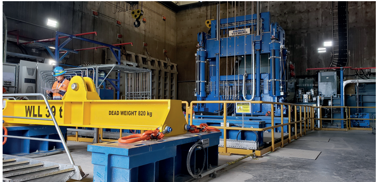
Instalacja 6-linowego urządzenia podciągająco-klemującego w szybie 2 kopalni Oyu Tolgoi.
